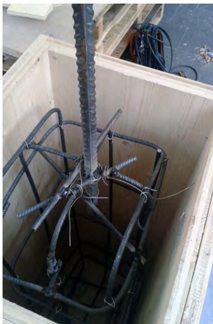
Coffrage de l'œuvre de Rita Sajeva
